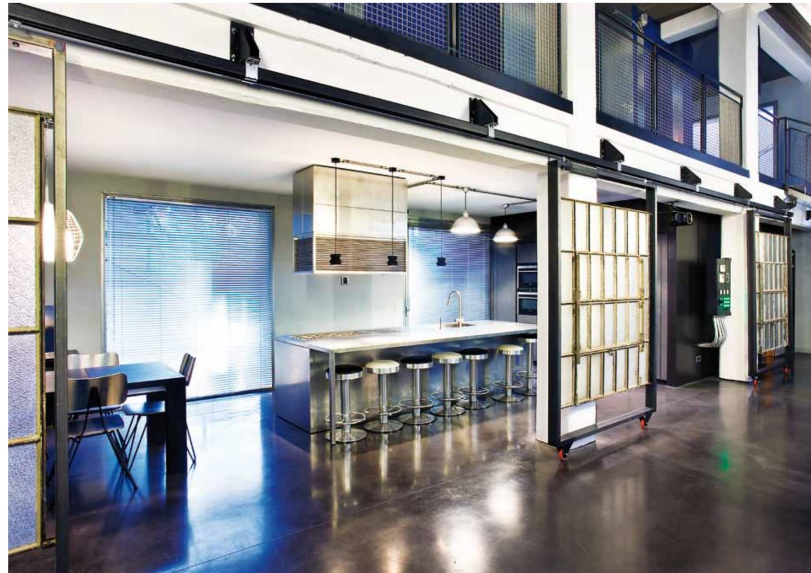
Tutte le forometrie preesistenti sono state più o meno modificate: al primo piano sia per realizzare un nuovo cassonetto per le tende oscuranti a rullo, sia per poter creare un basso zoccolo inferiore. Al piano terra invece, si è ampliata la luce delle finestrate abbassando la soglia a filo pavimento e non prevedendo il cassonetto superiore.
